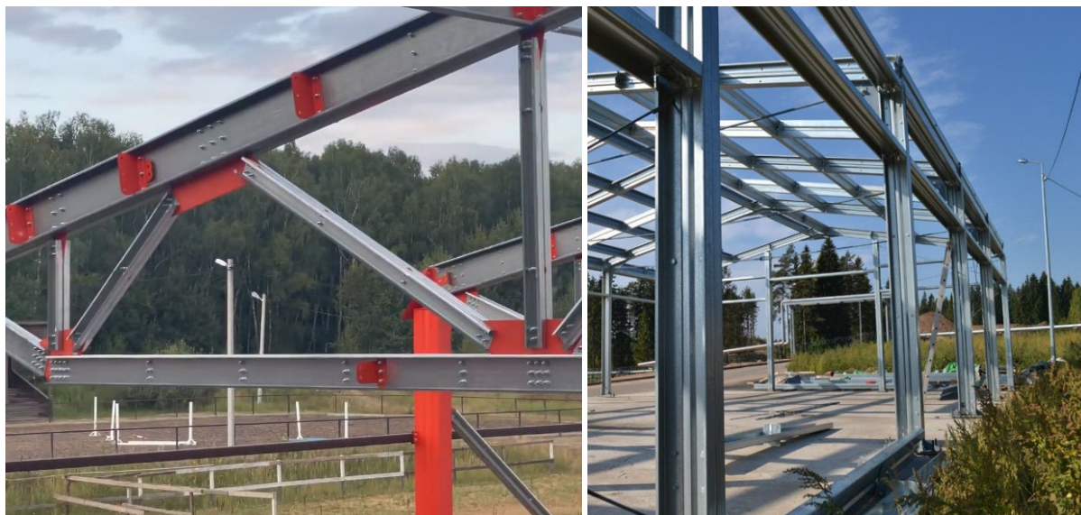
Рис. 1. Примеры применения легких стальных тонкостенных конструкций
