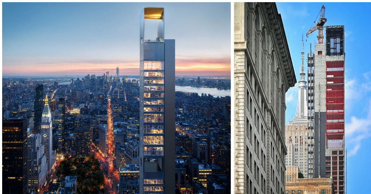
Рис. 6. Пустоты в верхней части здания 262 на 5 авеню на визуализации и в процессе строительства
