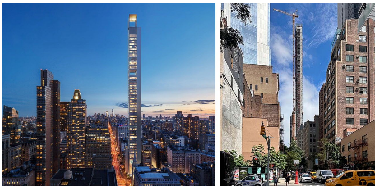
Рис. 2. Визуализация (слева) и фото строительства здания 262 на 5 авеню летом 2025 г.
